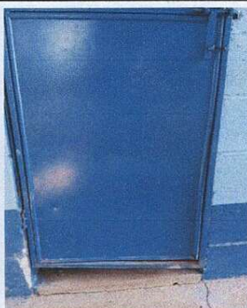
Foto 5: Reparación de puertas en mal estado.
