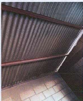
Foto 3: Sustitución de lámina en mal estado, por lámina troquelada calibre 26 y mantenimiento a estructura.
