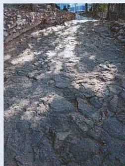
Foto 4: Reparación a losa de patio a ingreso principal al establecimiento.
