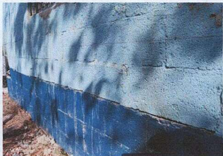
Foto1: Colocación de pintura en muros.
